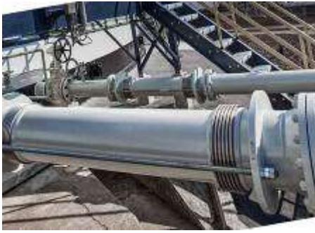
Сильфонный компенсатор
